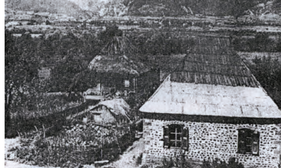
Tipovi kuća u Ržanici: stara brvnara pokrivena slamom i pored nje novija kuća od kamena pod šindrom, izvor: Lutovac, M. (1957) Ivangradaska (Beranska) kotlina , sl. 38, str. 110
