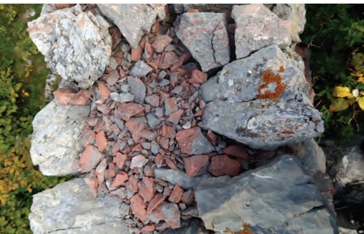
Način zidanja zida, katuni Roman/Romon i Mali Mojan
