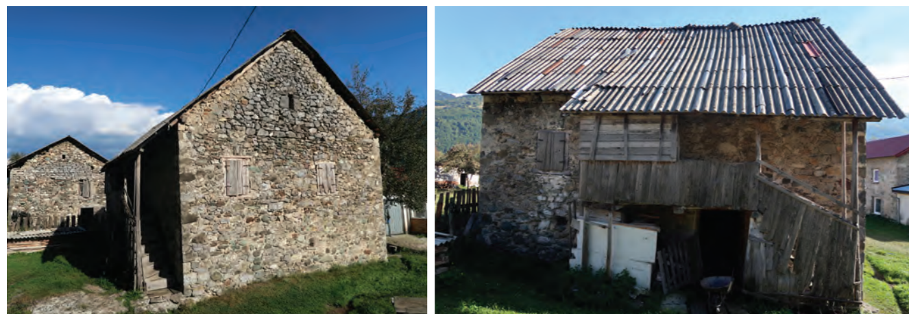
Kuća pravougaone osnove sa dvovodnim krovom, Martinovići
