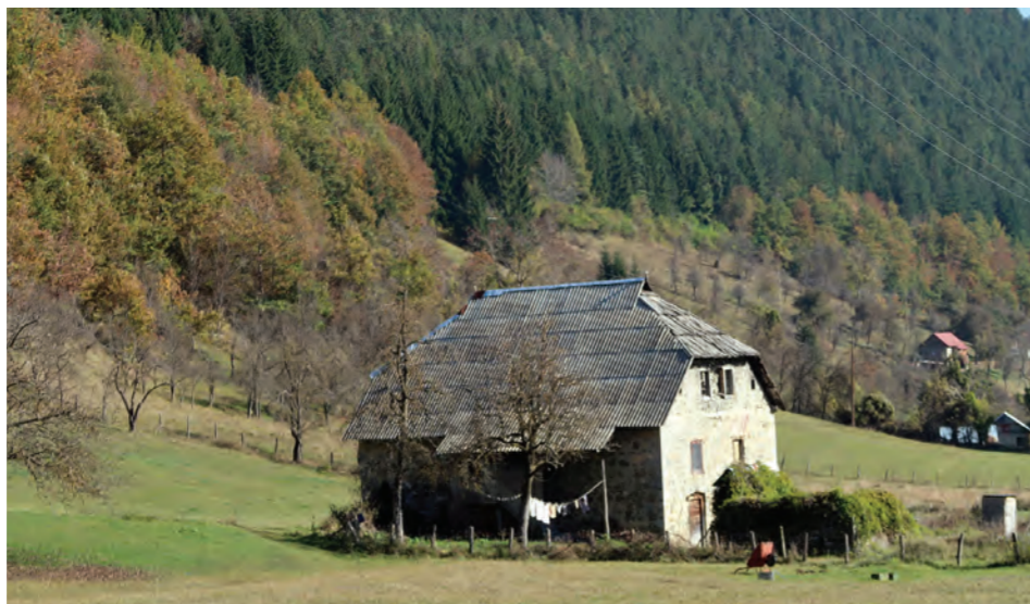
Kuća sa zabatnim zidom od kamena i očuvanim dijelom krova pokrivenim šindrom, Dolja
