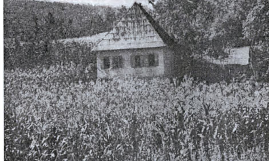
Tip kuće čatmare (donji boj od kamena a gornji od čatme); izvor: Lutovac, M. (1957) Ivangradaska (Beranska) kotlina , sl. 39, str. 111
