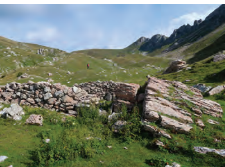
Primjer koliba koje koriste postojeće stijene kao dio konstrukcije, katuni Veliki Mojan i Roman/Romon
