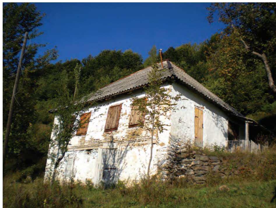
Bočni zid od kamena a prednji od čatme, zona od Velike prema Čakoru
