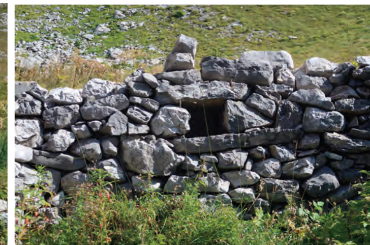
Detalj sloga kamena kod otvora za vrata i niša u zidu, katun Ramon/Romon,
