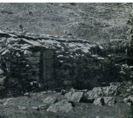
Pastirka koliba iz suhozida na Trojanu; izvor: Gušić, B. (1964), Brada u Prokletijama , str. 59
