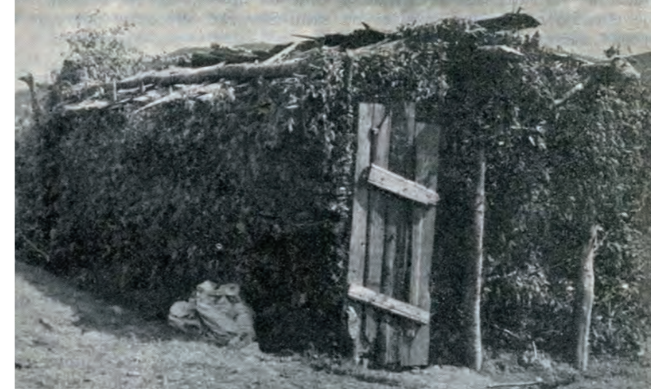
Pastirska koliba od pletenog šiblja na Kodri, na Prokletijama; izvor: Gušić, B. (1964) Brada u Prokletijama , str. 67
